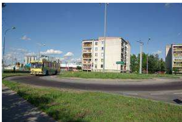
Fot.15. Skrzyżowanie- rondo ul. Poznańskiej z ul. Mała Kraska.
