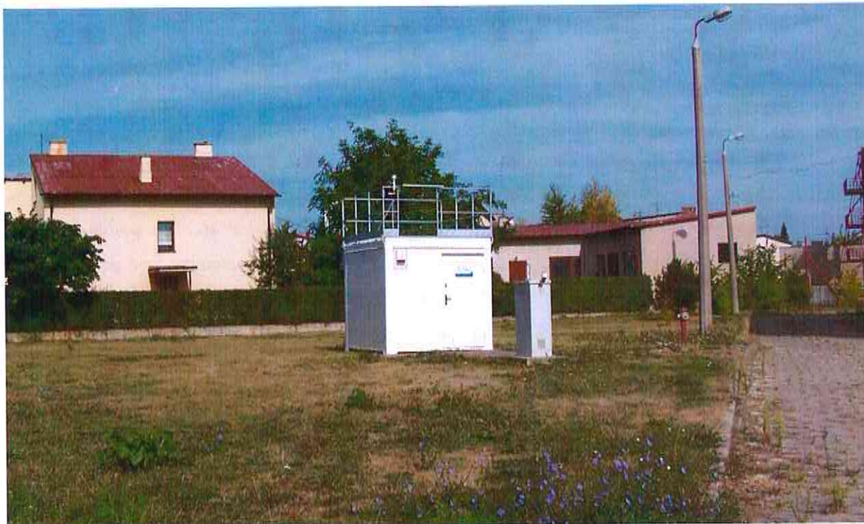
Fot. 1. Stacja monitoringu zanieczyszczenia powietrza atmosferycznego przy ul. Sikorskiego 94/98 w Łomży (po modernizacji).
