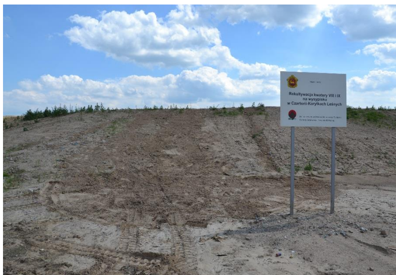
Fot. 2. Stara część składowiska odpadów w Czartorii – bezpośrednio po zakończeniu prac rekultywacyjnych w czerwcu 2016 r.
