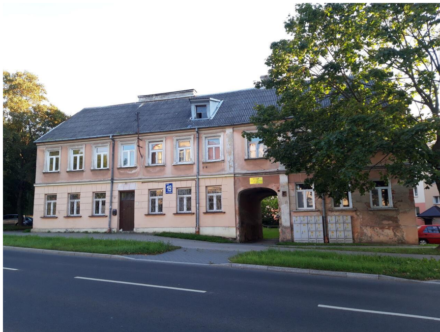
Fot. 13. Zabytkowa kamienica przy ul. Polowej 19
