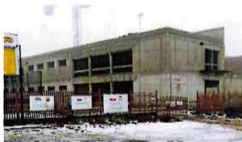
Fot.2. Budowa hali sportowej przy SP 5, fot. mylomza.pl
