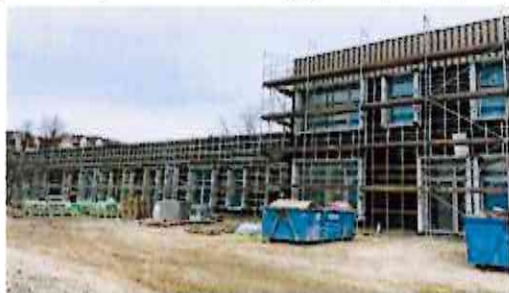
Fot.1. Budowa Przedszkola nr 5, fot. Miasto Łomża
