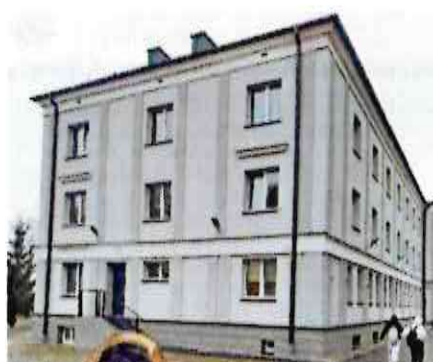
Fot.4. Bursa Szkolna nr 2 po remoncie, fot. PSSE w Łomży
