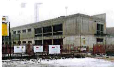
Fot.2. Budowa hali sportowej przy SP 5, fot. mylomza.pl
