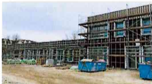
Fot.1. Budowa Przedszkola nr 5, fot. Miasto Łomża
