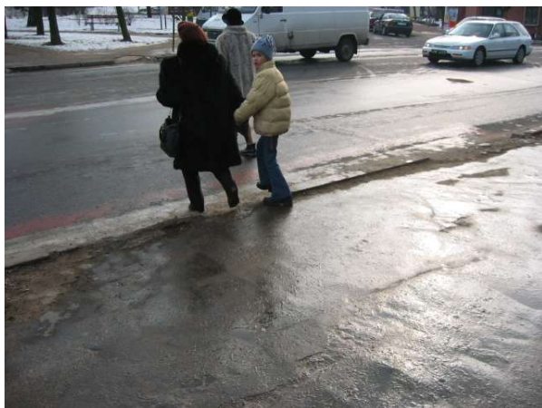
Fot. 36. Plac Kościuszki – zły stan oznakowania poziomego przejścia dla pieszych
