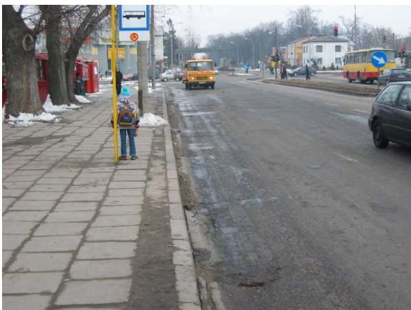
Fot. 31 Przystanek na ul. Legionów przy dworcu PKS. Widoczne nierówności chodnika i jezdni
