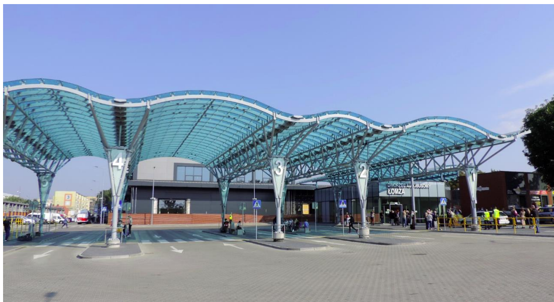
Rysunek 2. Centrum przesiadkowo-komunikacyjne w Łomży, fot. Adam Dąbrowski
